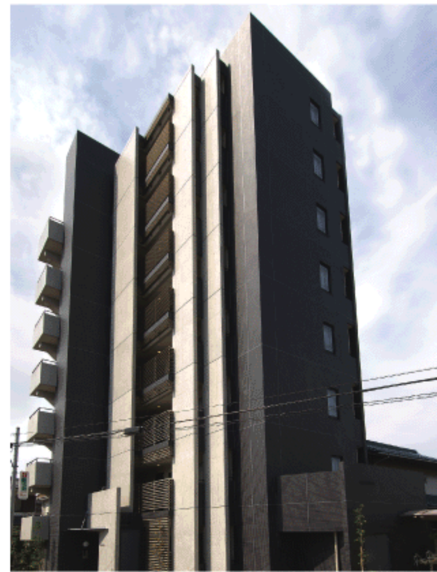
ソシオ町田 外観 (2005年6月竣工)
